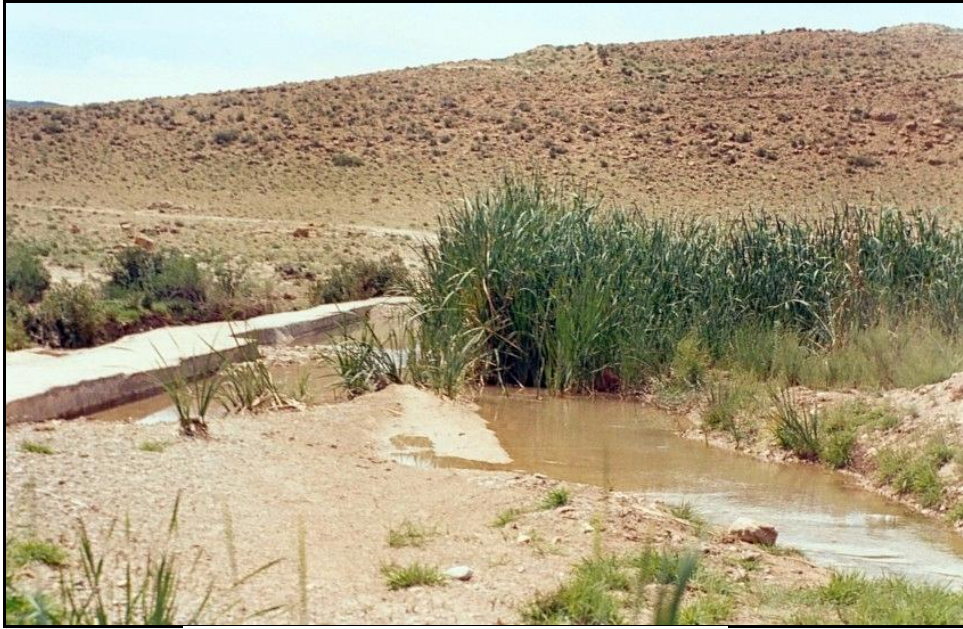
الصورة 46: سد الخشم
